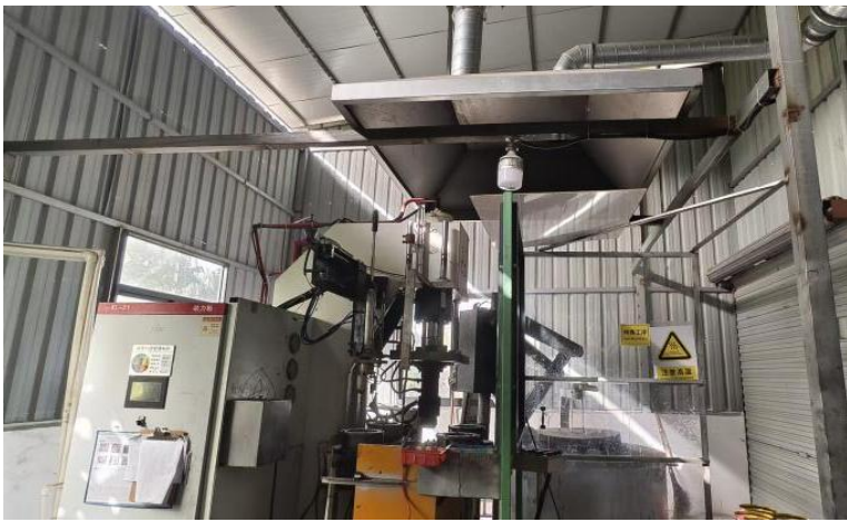
图 3.2-3 转子注铝废气收集处理设施照片
