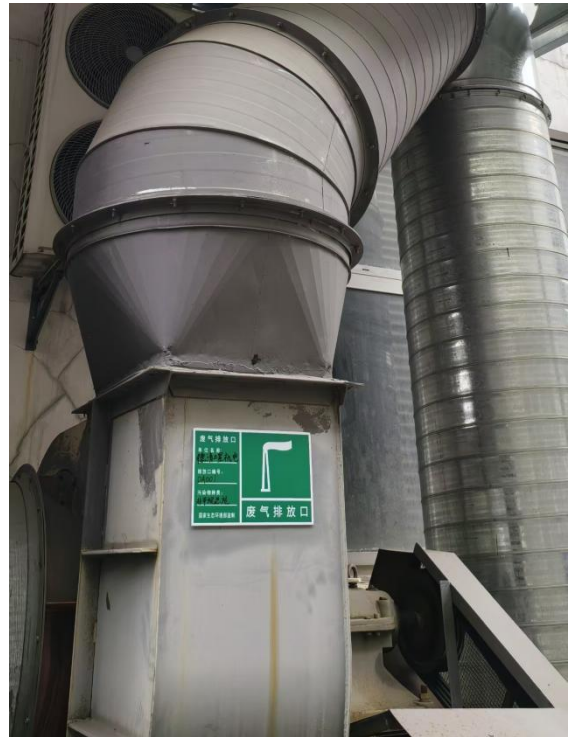
图 3.2-1 注塑收集处理设施照片
