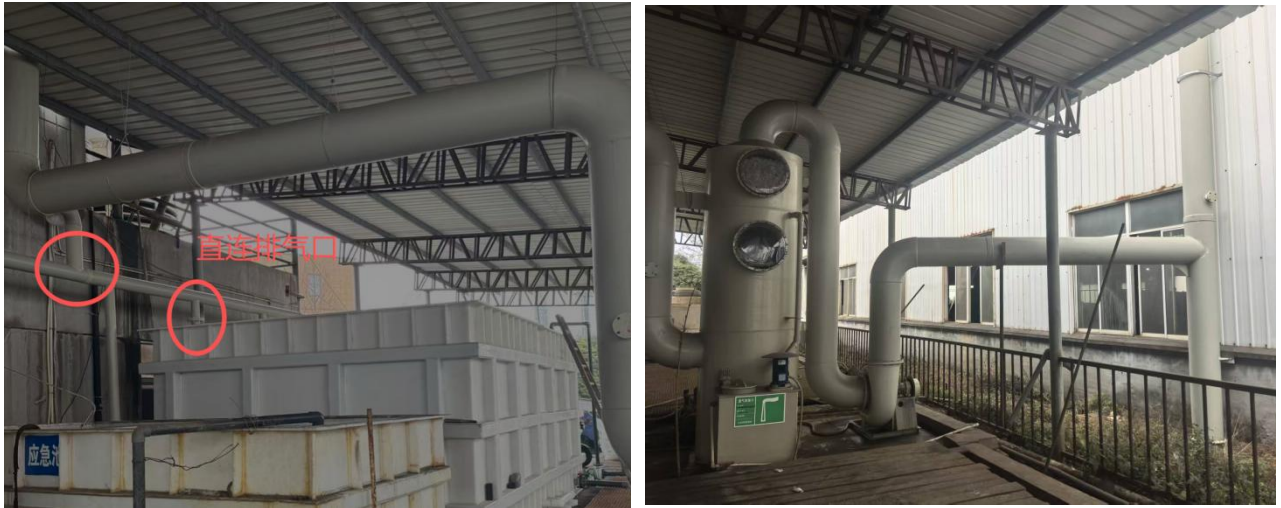
图 3.2-2 硫酸回用池酸雾废气的收集与处理装置照片
