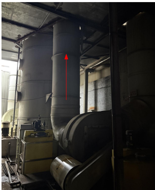
图 3.2-1 盐酸酸洗和盐酸储罐呼吸废气收集及处理装置照片
