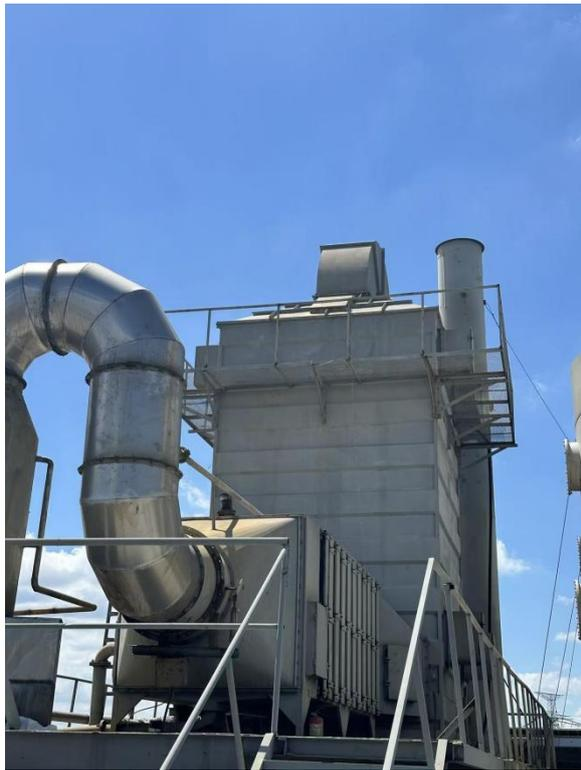
图 3-5 定型、天然气燃烧废气处理设施及排气筒
