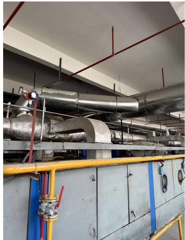
图 3-4 定型、天然气燃烧废气收集措施
