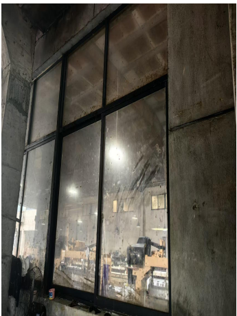
图 4.1-1 本项目噪声治理措施照片（隔声门窗、隔音屏障等）
